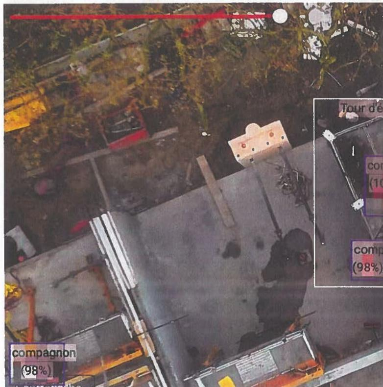
CAD.42 propose un boîtier (visible en noir sur la grue) qui, grâce à l'IA, permet de détecter des situations à risques sur un chantier. Le responsable du chantier reçoit en fin de journée un rapport sur les situations détectées et peut ainsi agir pour éviter qu'elles ne se reproduisent.
